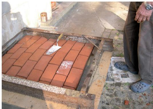
Fig. 4 - Esempio costruttivo di voltine
