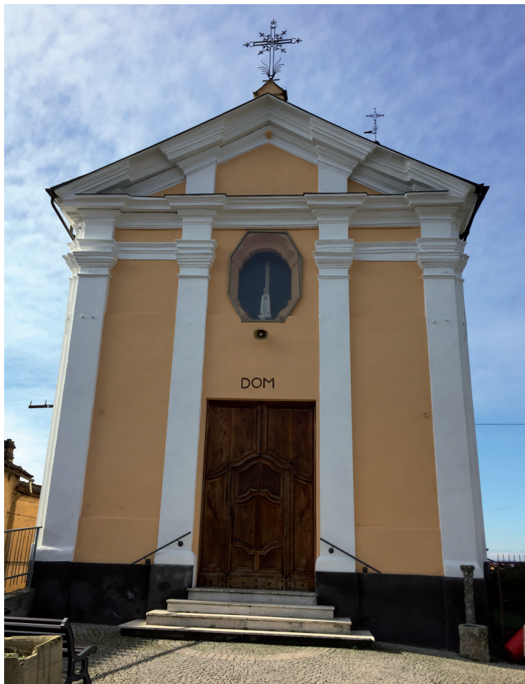
La facciata della Chiesa dei Battuti, restaurata di recente
