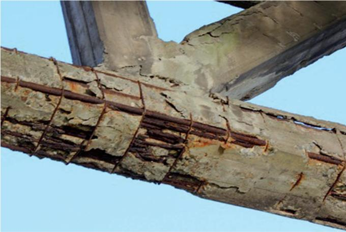
Fig. 3 - Scorticamento di una trave in c.a. per effetto della carbonatazione
