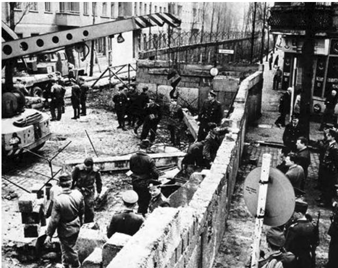
13 agosto 1961: la costruzione del muro
