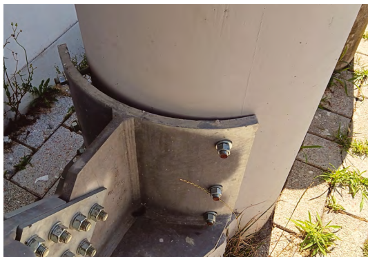
Fig. 6 - Particolare dell'ancoraggio alla colonna
